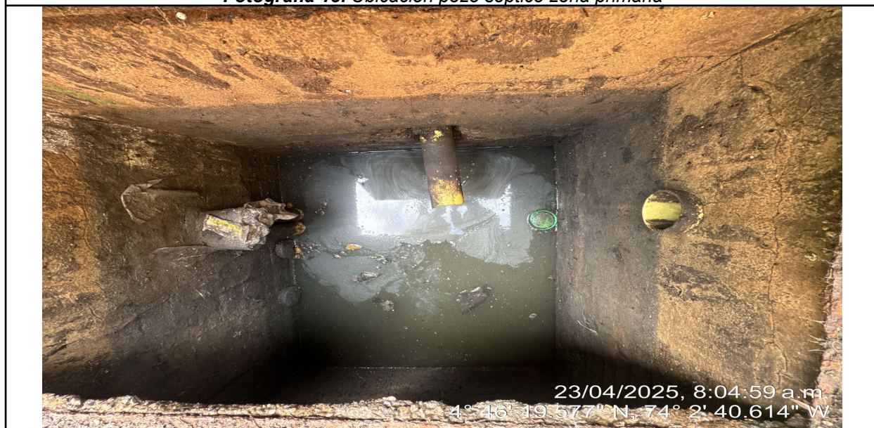
Fotografía 14. Primer compartimiento pozo séptico zona primaria.
