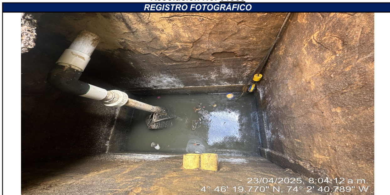
Fotografía 15. Segundo compartimiento pozo séptico zona primaria.
