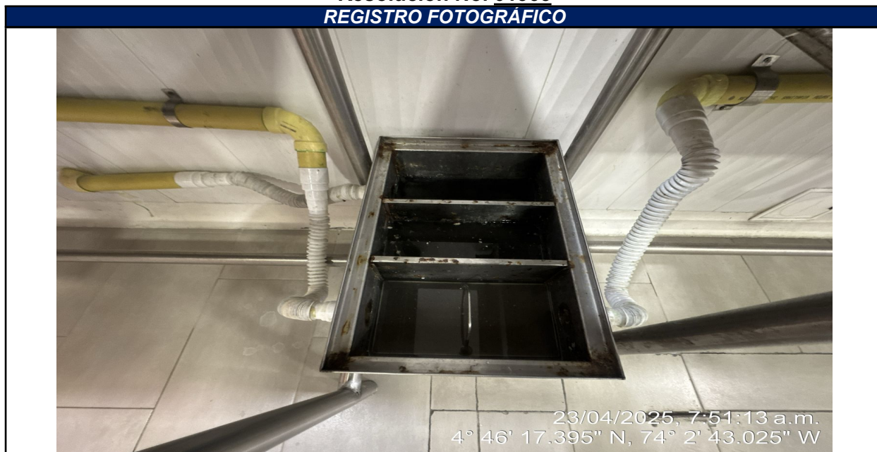
Fotografía 3. Trampa de grasas interna cocina zona bachillerato.
