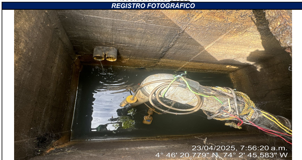
Fotografía 11. Segundo compartimiento pozo séptico zona preescolar.
